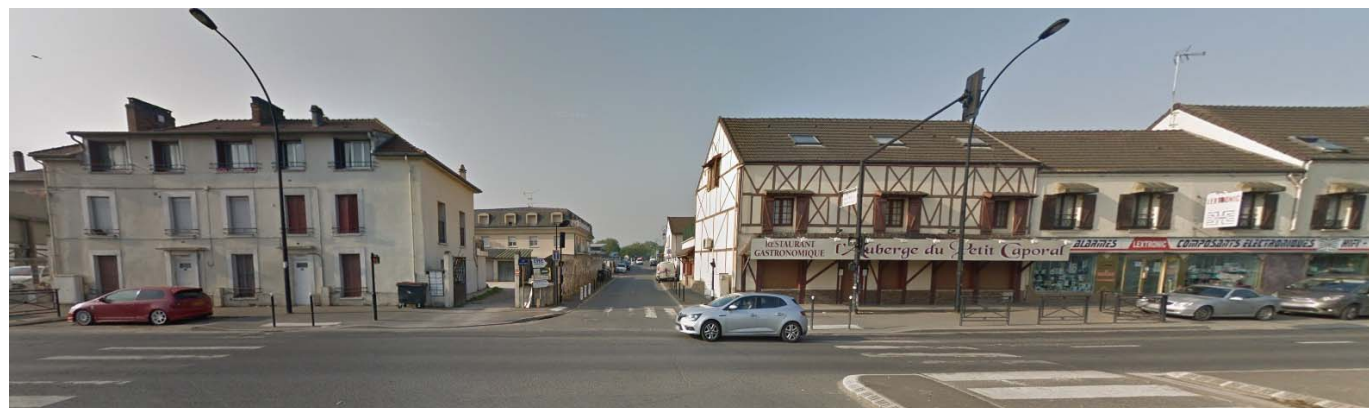
Figure 8 : Les bâtiments de logements de la route de Brie (Google, 2019)
