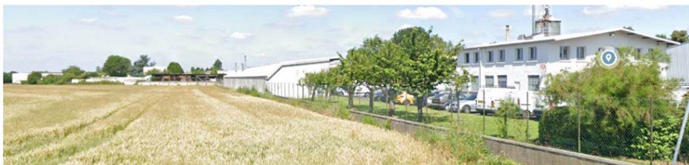
Environnement bâti situés à proximité des bâtiments projetés
