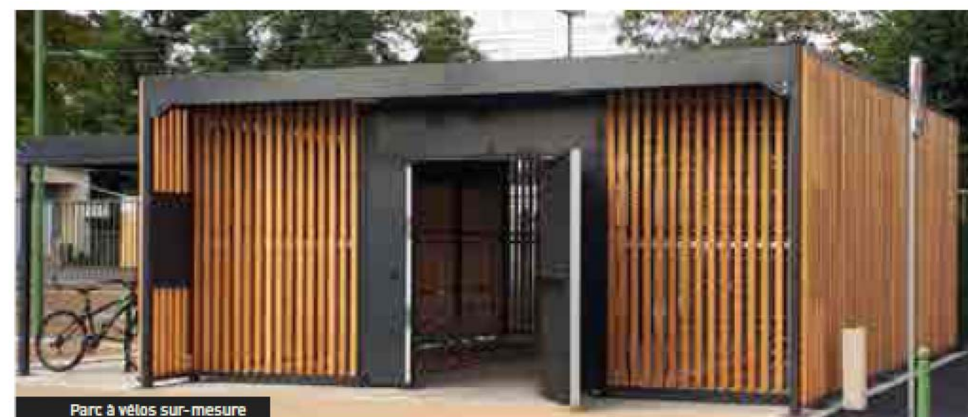
Parti architectural des locaux vélo (à gauche) et des locaux à déchets (à droite)
