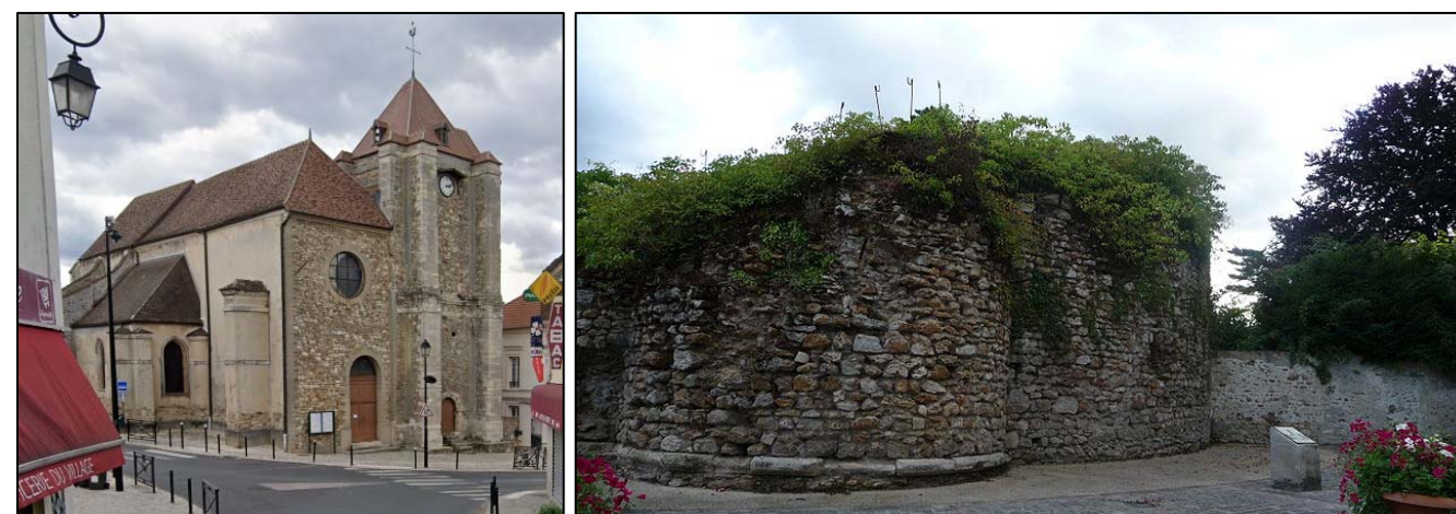
Figures 13 et 14 : Eglise Saint-Nicolas et vestiges de la grosse tour à la Queue-en-Brie (Google Maps, 2021 et Al.pliar)
