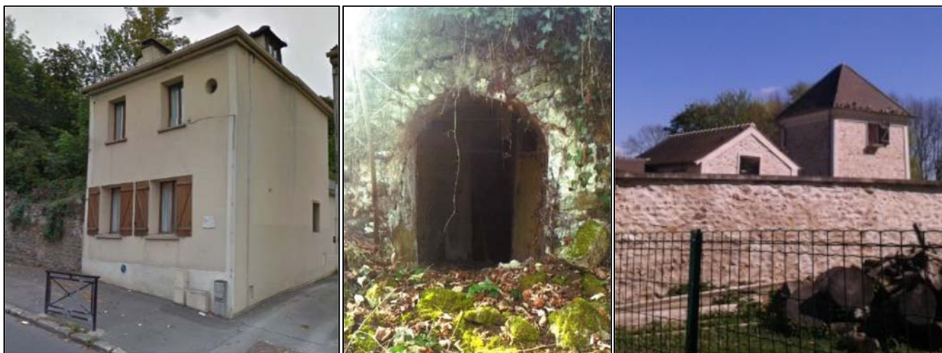
Figures 15, 16 et 17 : Maison Degas, glacière de l'entrée du Parc Rouart et Pigeonnier (Règlement du PLU de la Queue-en-Brie, 2015)
