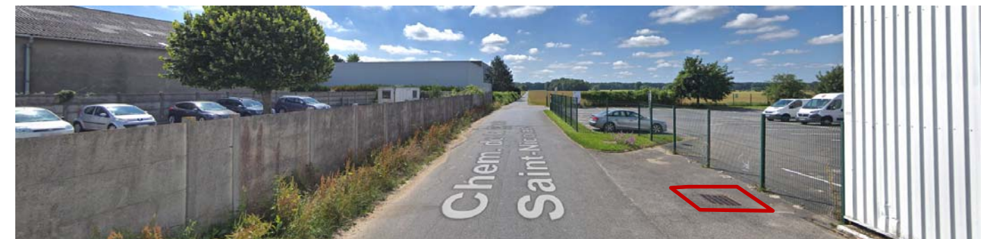
Figure 9: accotement enherbé et grilles d'évacuation des eaux pluviales le long du chemin de la Croix-Saint-Nicolas (Google Maps, 2020)
