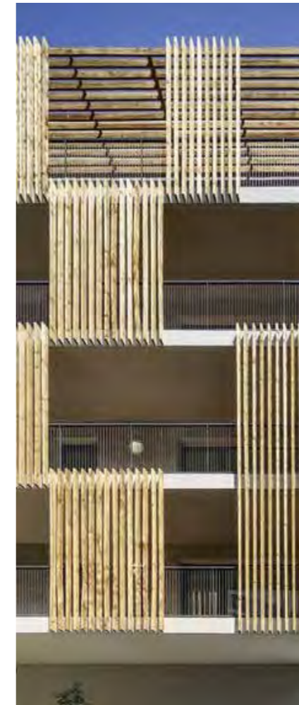
Façade en bois, JP Gomis Architecture, Nice
