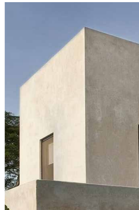
Façade enduit à la chaux
