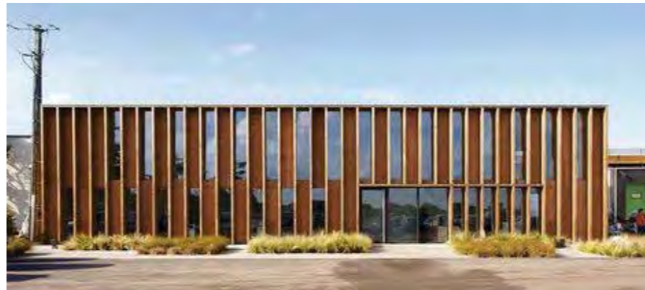
Traitement de façade latérale
