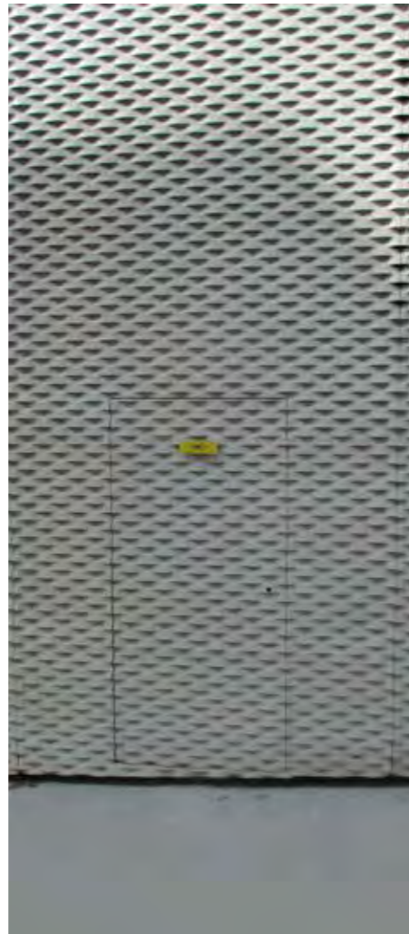
Coffrets intégrés à la façade
