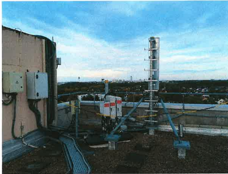
Vue de la terrasse S1 avant travaux
