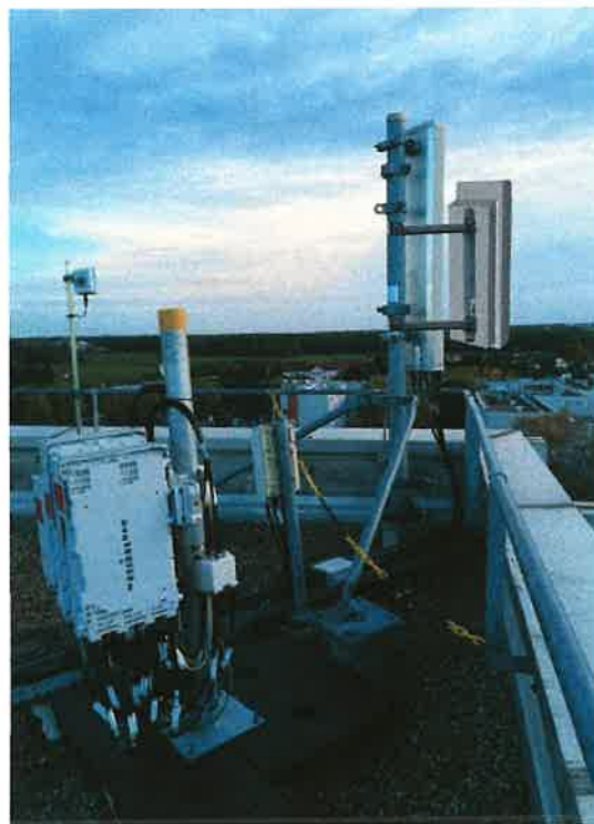
Vue de la terrasse S1 après travaux
