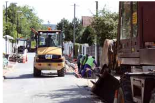
Travaux de voirie : rue Ernest Renan
