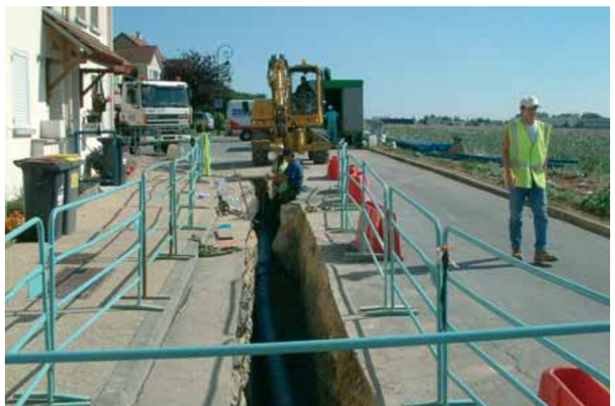
Travaux de voirie, Chemin de la montagne
